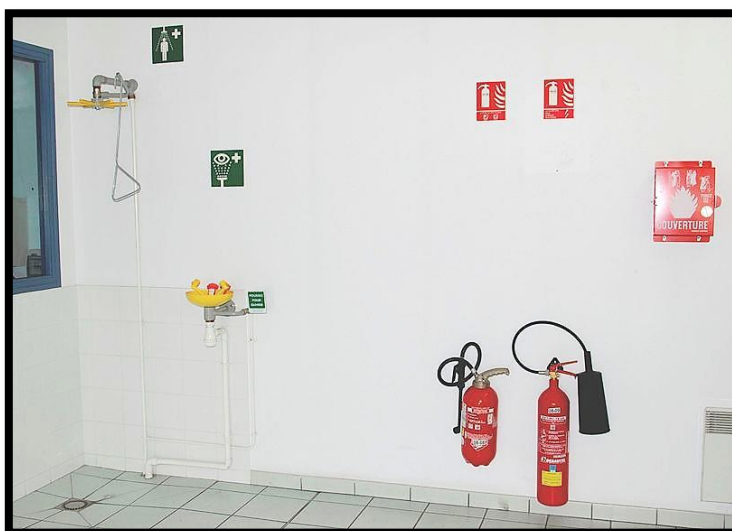
Figure.1. Moyens de sécurité (à maintenir dégagés et à vérifier périodiquement), avec leur pictogramme, en laboratoire de chimie.
